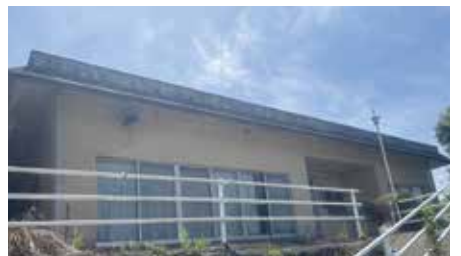
解体予定の旧唐隈公民館
