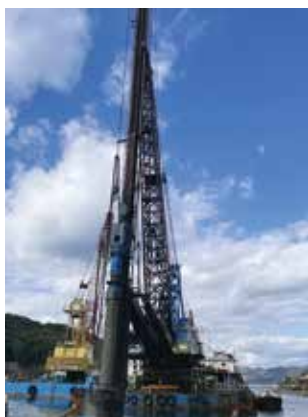
工事が進む長島港白瀬地区
