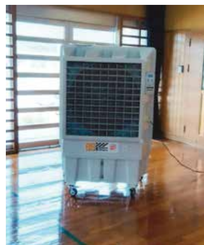
町武道館に設置されている気化式冷風機
