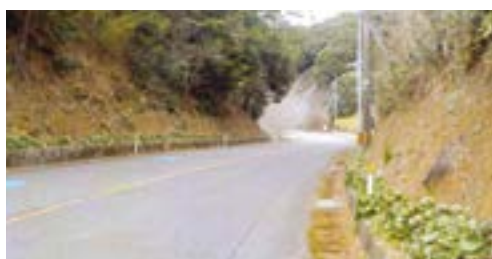
石張り未整備の法面(汐見地区)
