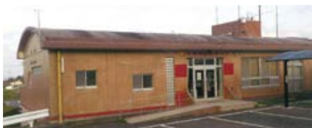
食材保管場所の候補地となる消防拠点施設
