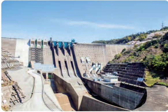
治水と発電を目的に昭和41年に完成した鶴田ダムは、高さ117.5mで重力式コンクリートダムとしては九州最大の規模を誇ります。河川空間のオープン化によるインフラツーリズムの一環で、令和5年から開催されている秋の「大鶴湖まつり」では、堤体内見学やダムの放流を間近に見ることが出来ます。
