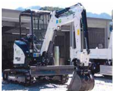
油圧ショベルやダンプが配備される
