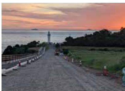
長崎鼻灯台へと続く町道
