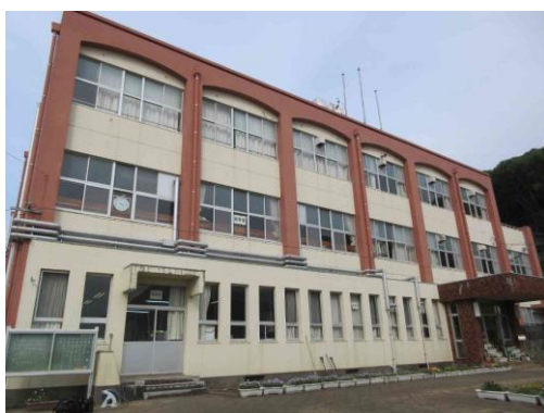
管理棟（昭和 55 年築）
