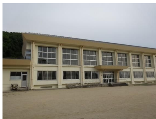
屋内運動場（平成 17 年築）
