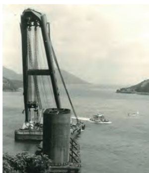
建設中の橋脚と黒之瀬戸丸
