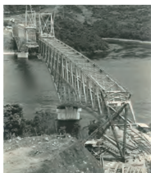
建設中の橋（閉合前）
