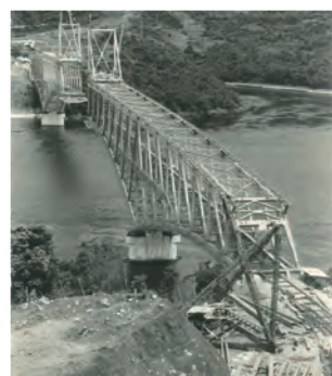
建設中の橋（閉合前）
