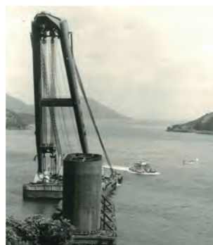
建設中の橋脚と黒之瀬戸丸
