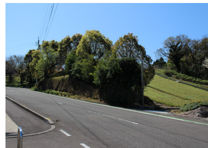
駐車帯を整備予定の草スキー場周辺
