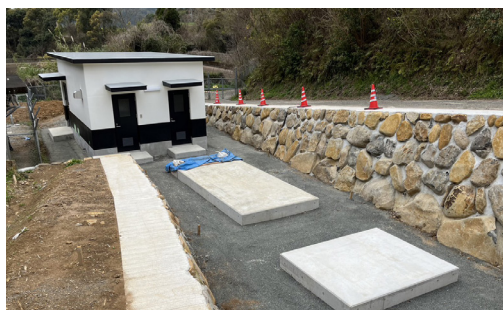
完成した伊唐水源地の建屋
