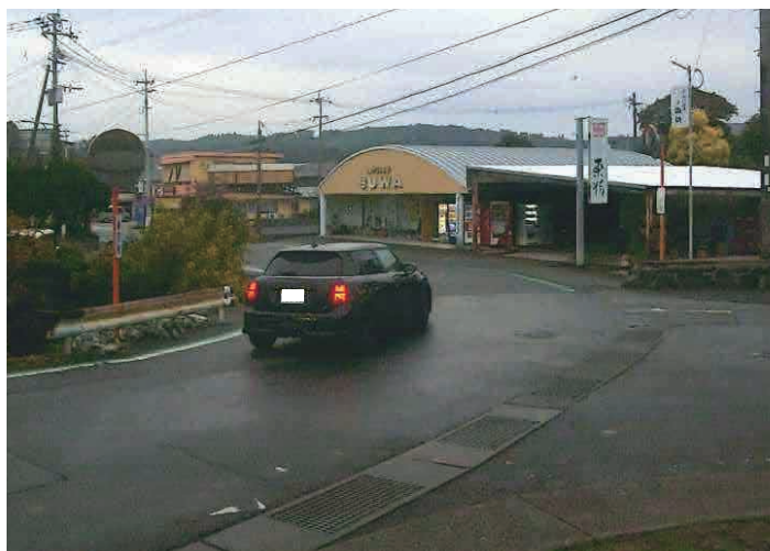
幅員が狭く、見通しが悪い道路
