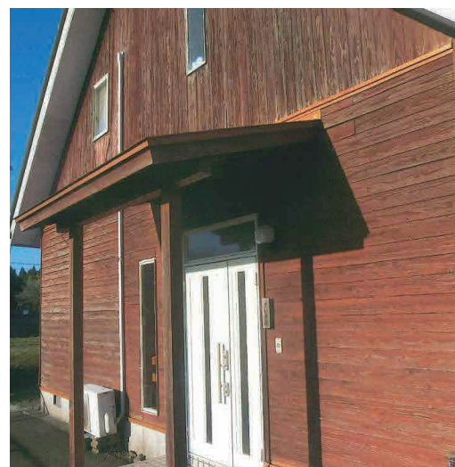
稼働率向上が求められるケビン
