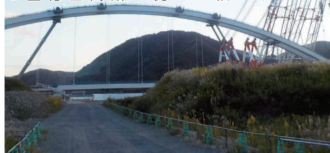
架橋目前のアーチ橋と大型クレーン(女川町)
