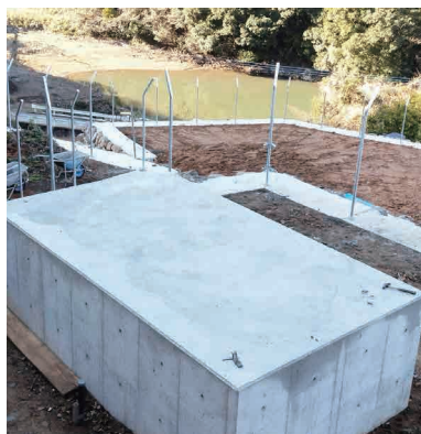
工事が進む浄水場建設地
