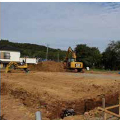
工事が始まった格納庫予定地(平尾)
