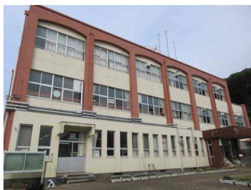
管理棟（昭和 55 年築）
