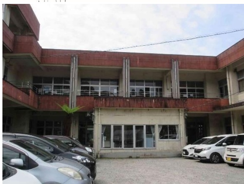
管理棟（昭和 62 年築）
