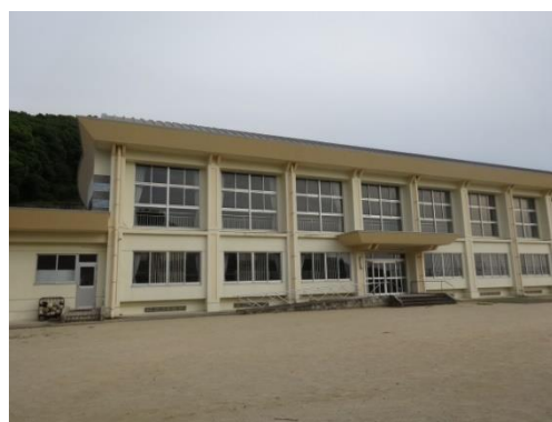
屋内運動場（平成 17 年築）
