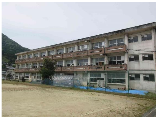
管理教室棟（昭和 48 年築）
