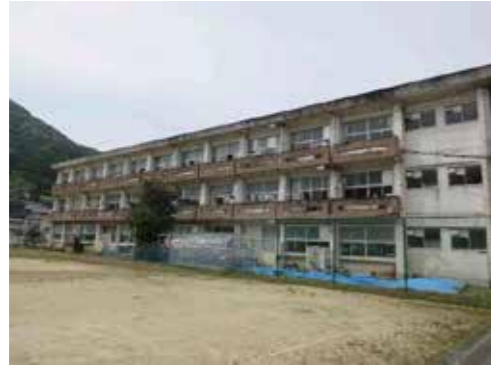
管理教室棟（昭和 48 年築）
