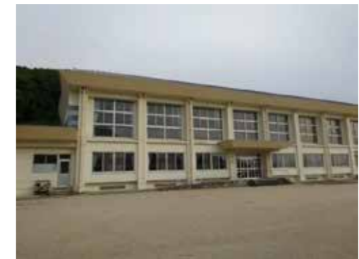
屋内運動場（平成 17 年築）
