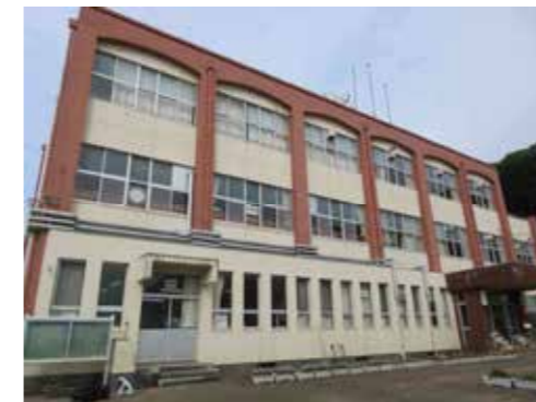
管理棟（昭和 55 年築）
