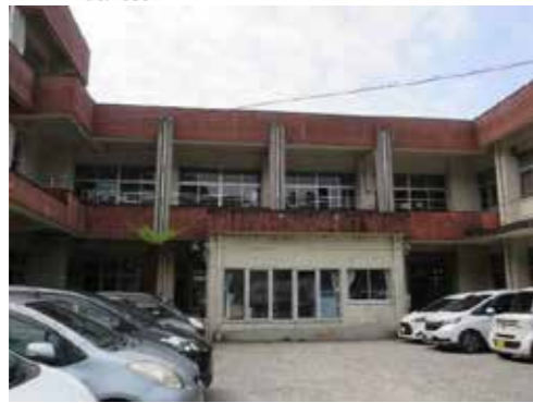
管理棟（昭和 62 年築）
