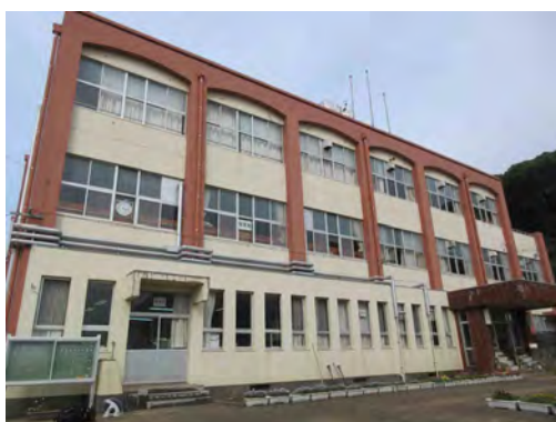
管理棟（昭和 55 年築）
