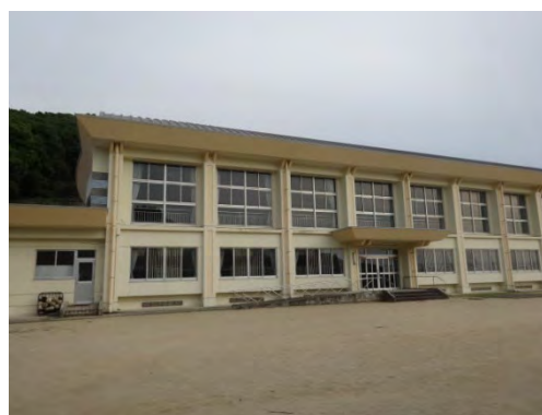
屋内運動場（平成 17 年築）
