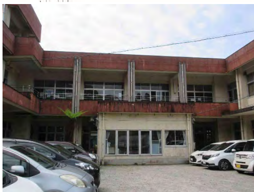
管理棟（昭和 62 年築）
