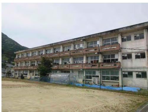
管理教室棟（昭和 48 年築）
