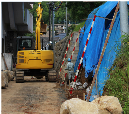
役場本庁舎法面改修事業
