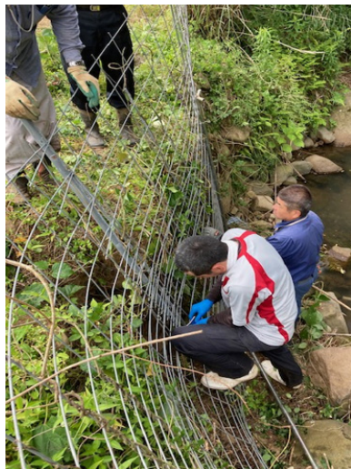
鳥獣被害防止のための柵を補修する様子
