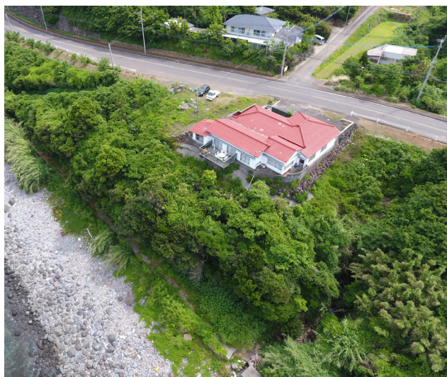
草が生い茂り確認が難しい国道下に面した遊歩道
