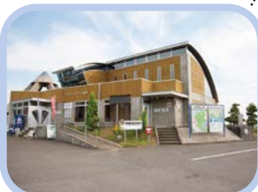
道の駅「望陽」Toilet
