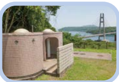
伊唐大橋公園Toilet
