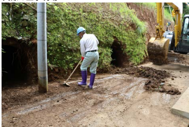
実際の工事現場
