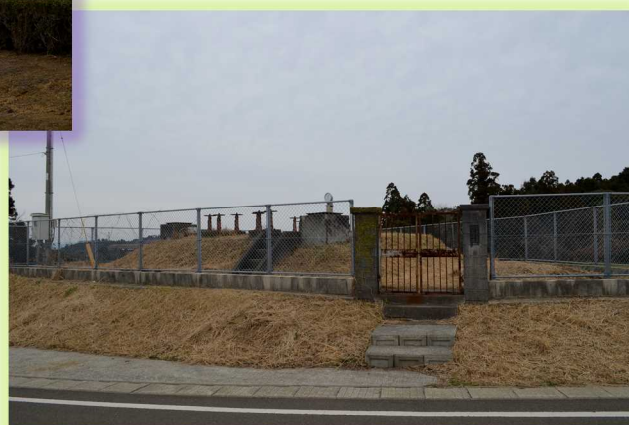
蔵之元高区配水池
