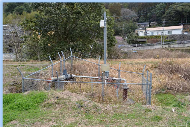
東部地区(浦底第2水源地)
