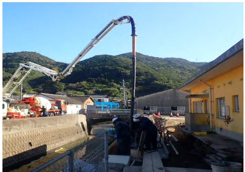
災害復旧工事の様子
