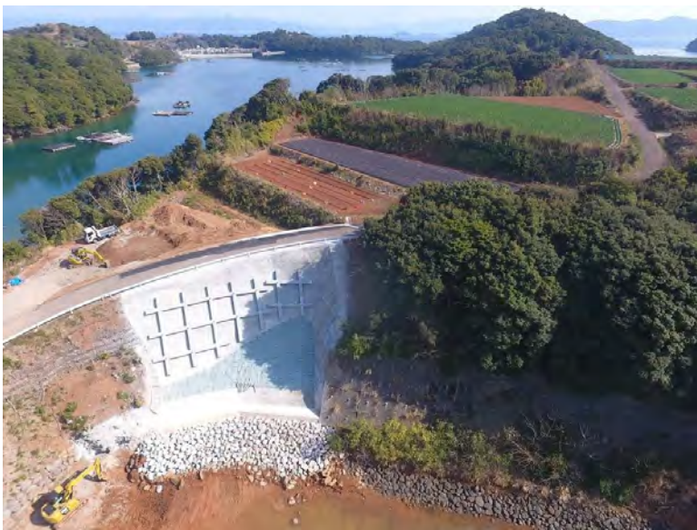
災害復旧後の様子
