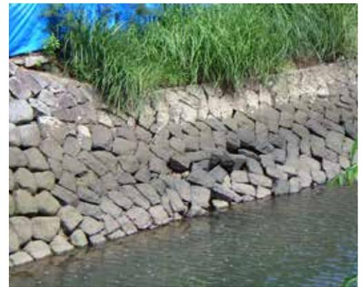
石が抜け落ち崩落寸前の石積み(小浜川沿い)
