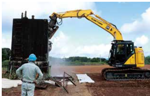
解体作業をする会員ら
