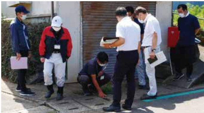
危険な通学路を点検する参加者
