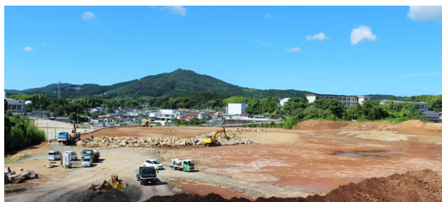
造成完成間近の運動公園（鷹巣）
