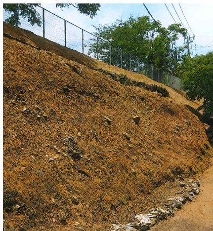
傾斜が急な役場横の法面
