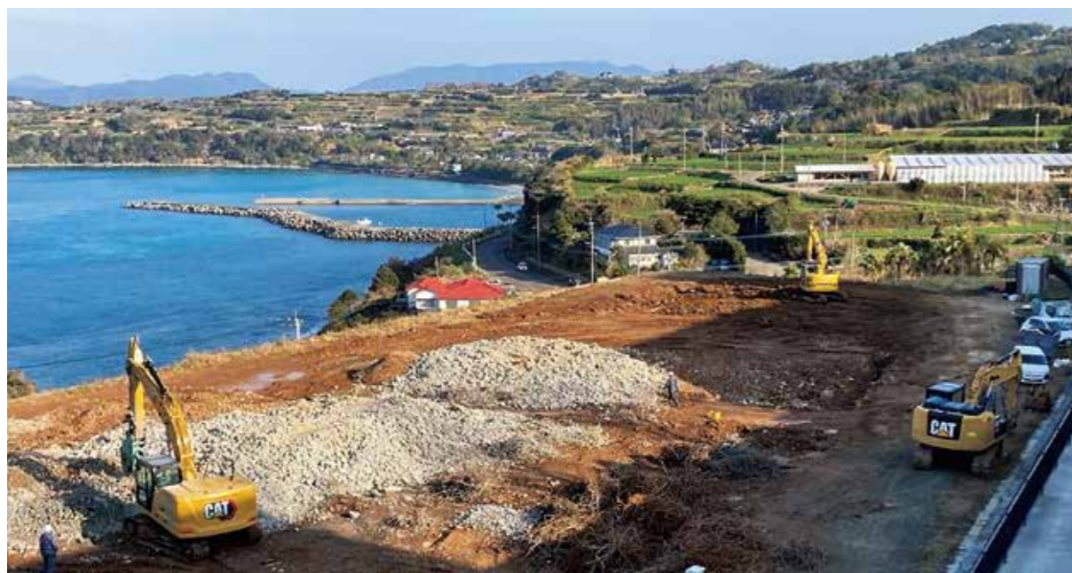
原状復旧工事の様子
