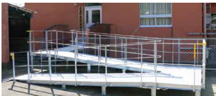
2階出入口のスロープ
