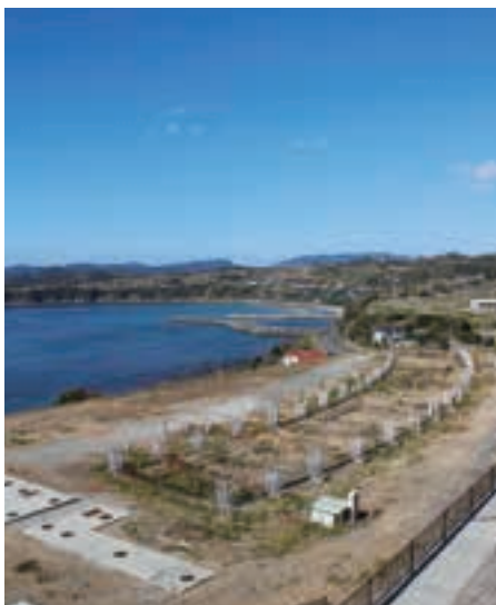
先行き不透明な大型宿泊施設建設予定地(指江、12月撮影)
