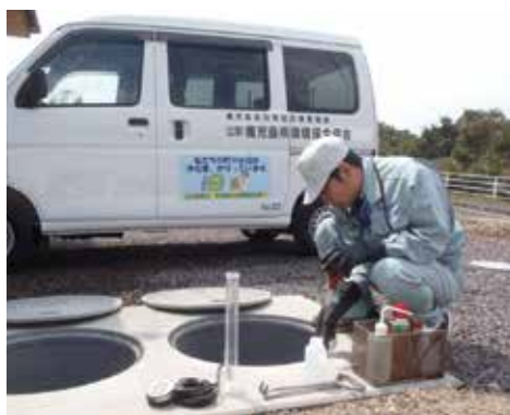
法定検査の様子
