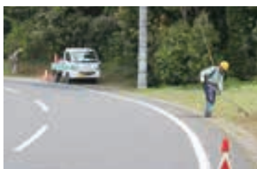
沿道で除草作業を行う作業員
