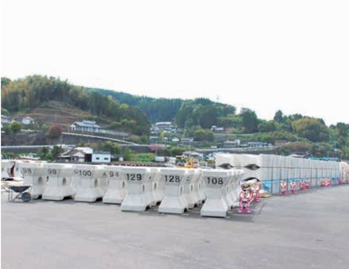
↑物揚場を利用した方塊ブロック
