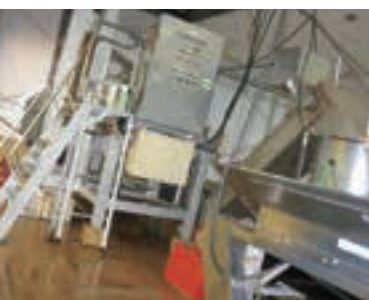
取替工事するいも蒸し器
