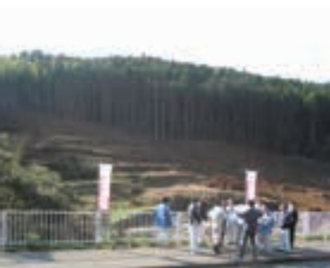
工事が進む山中地区多目的広場
