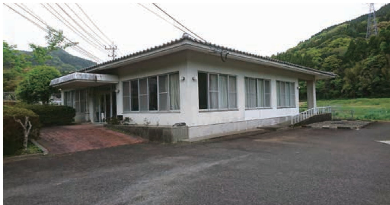
↑改修する山門野コミュニティセンター
