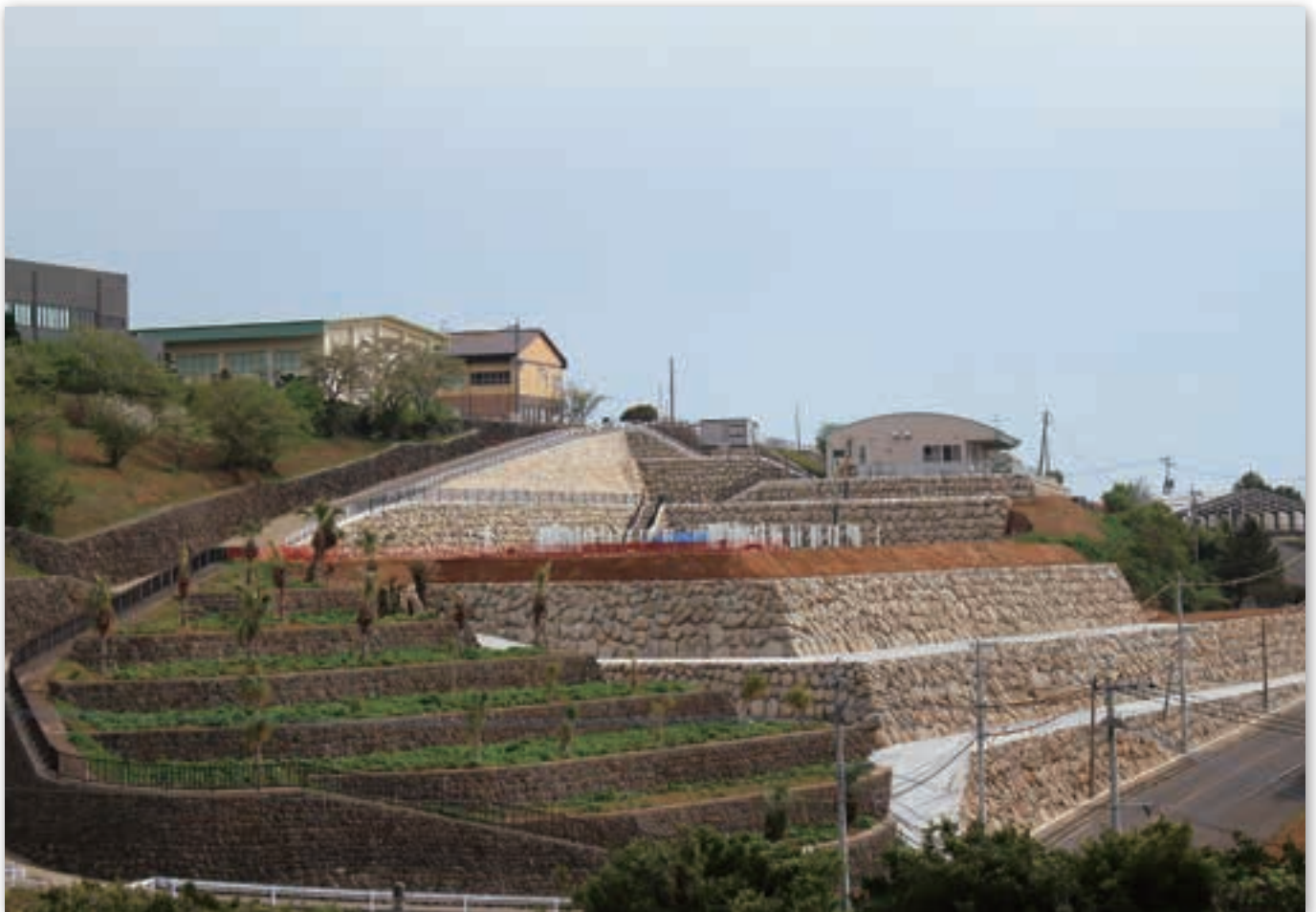
↑工事が進む大陸ホテル拠点整備に係る石積工事
