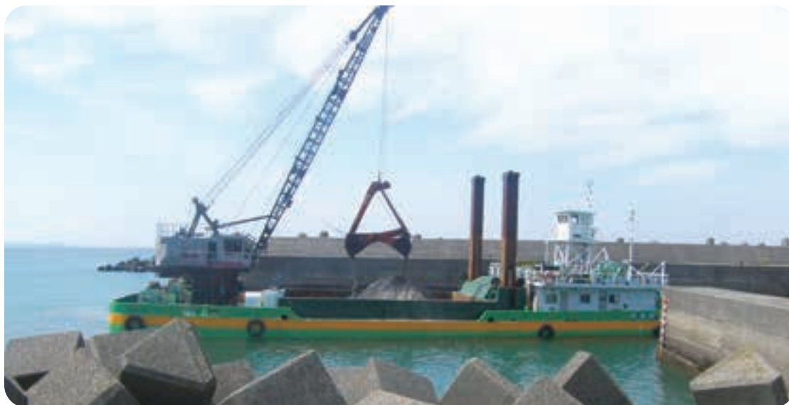
↑ 海底の土砂をすくいとる浚渫船（汐見漁港）
