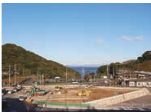
だんだん市場 新設駐車場トイレ新築工事 16,769 千円
