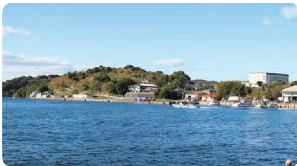
↑ 捨石 すていし が投入される長島港（伊唐地区）
