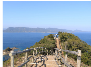
手すりなどを改修する黒崎空中展望所（獅子島）
