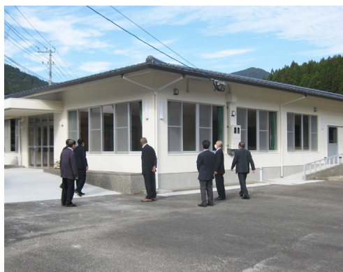
改修工事が完了した山門野コミュニティセンターを調査する総務民生常任委員会の委員
