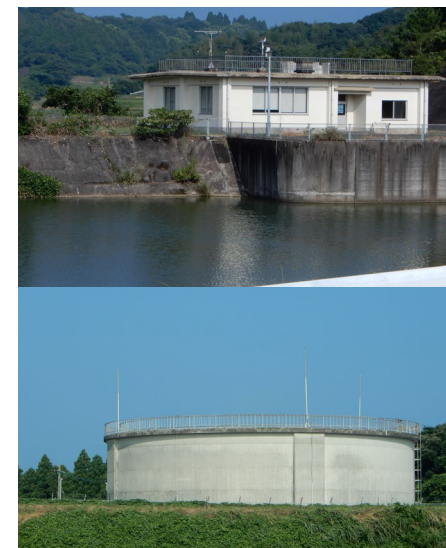
計測器が更新される鷹巣ダム事務所(上)と配水タンク
