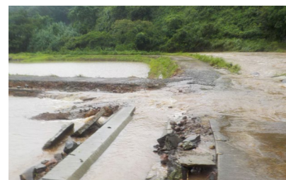
堤防が決壊し氾濫した小浜川（7月）
