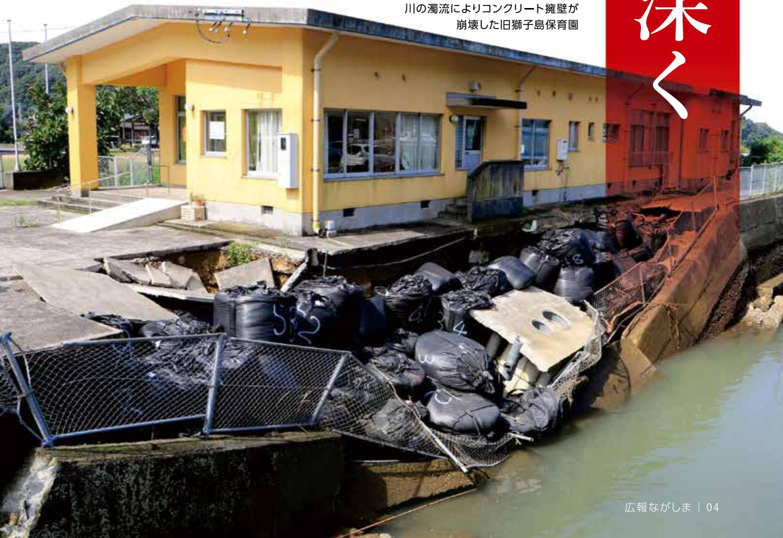
川の濁流によりコンクリート擁壁が崩壊した旧獅子島保育園
