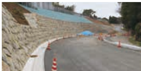
整備が進む浦汐屋茅屋線
