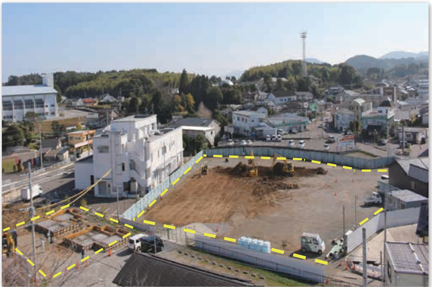
建設工事が始まった鷹巣診療所（囲み点線右側）と医師住宅（囲み点線左側）
