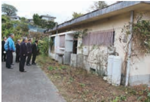
解体される町営住宅（城川内地区）
