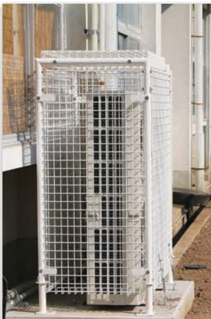
室外機を設置
