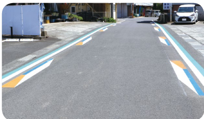
↑カラー標示施工された道路（鷹巣診療所前）
