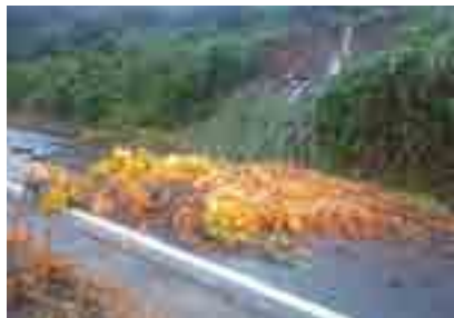
↑7月の豪雨により被災した町道平吹山寺線
