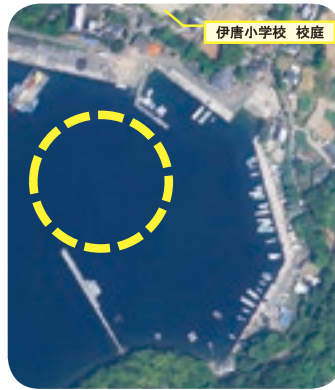
↑契約変更となった長島港（伊唐地区）（黄色の点線で囲まれた部分が整備予定地）
