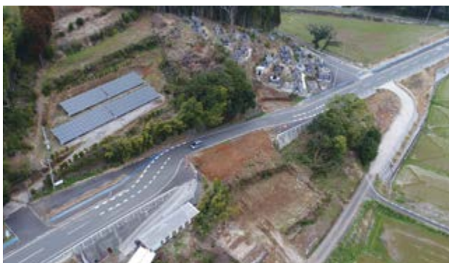
↑立ち並んでいた樹木の伐採が完了した最終工区
