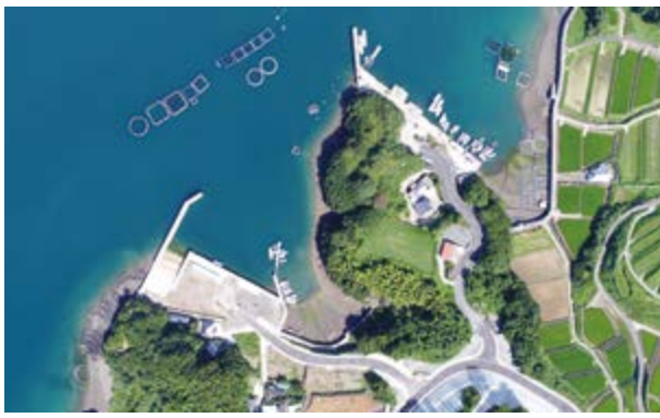
→契約が可決された社会資本整備総合交付金事業長島港（口）之福浦地区
