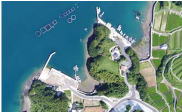
→契約が可決された社会資本整備総合交付金事業長島港（口）福浦地区
