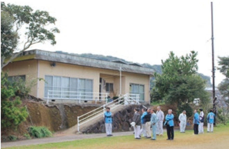
↑ 老朽化した唐隈自治公民館
