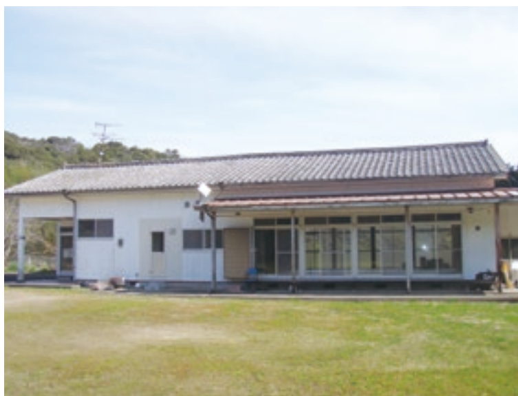
↑環境整備が望まれる諸浦コミュニティセンター
