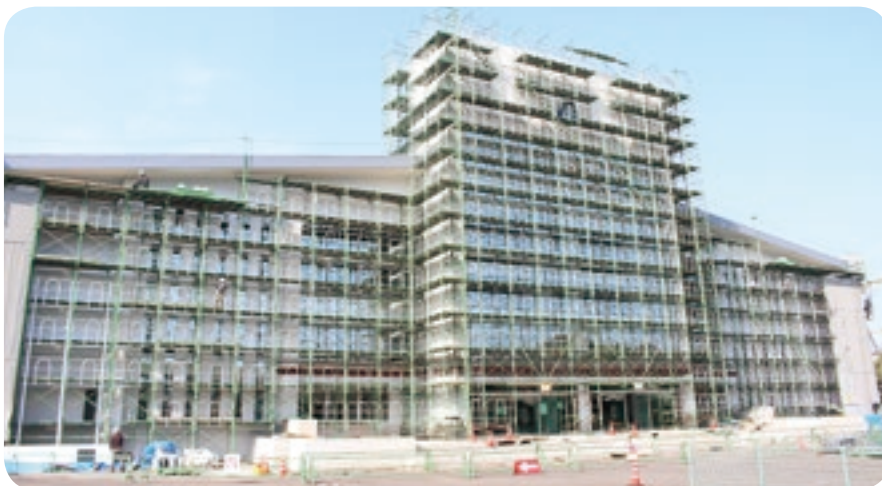
↑ 改修が進む総合町民体育館
