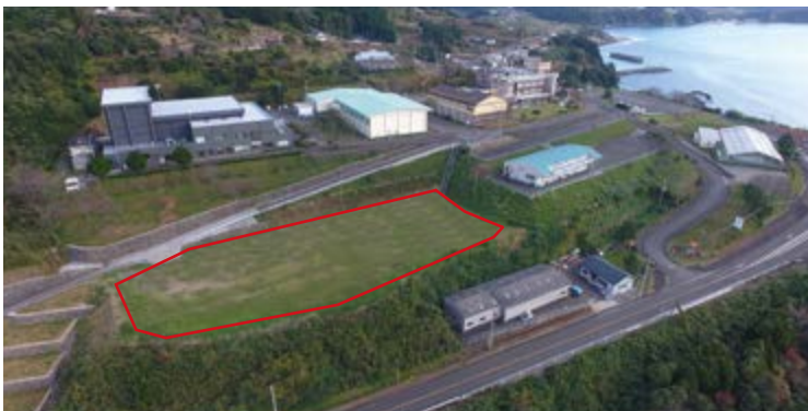
↑宿泊施設の建設予定地
