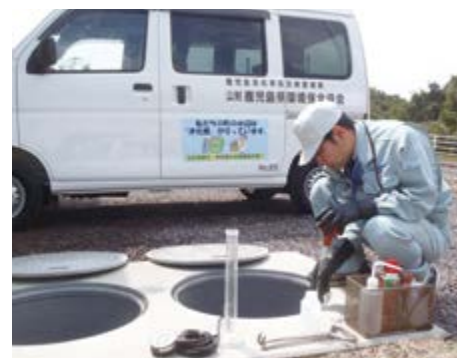
↑法定検査を行う検査員
