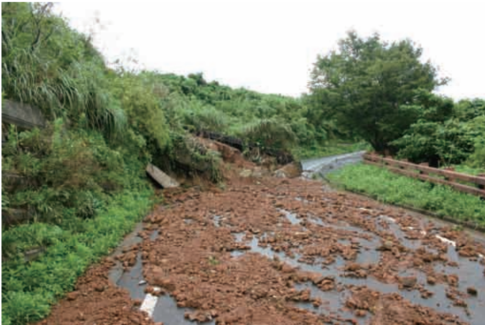
←土手が崩れて通行止めとなった道路（潟）
