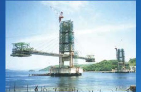
↑建設中の伊唐大橋(主桁の張り出し工事)
