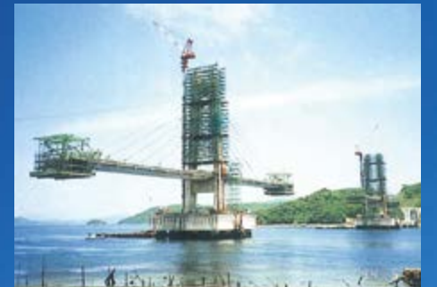
↑建設中の伊唐大橋（主桁の張り出し工事）
