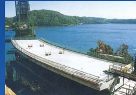
↑建設中の伊唐大橋（長島本島側）
