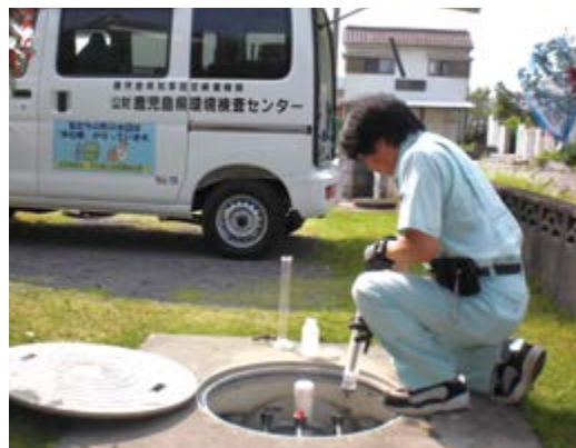
↑ 法定検査を行う検査員
