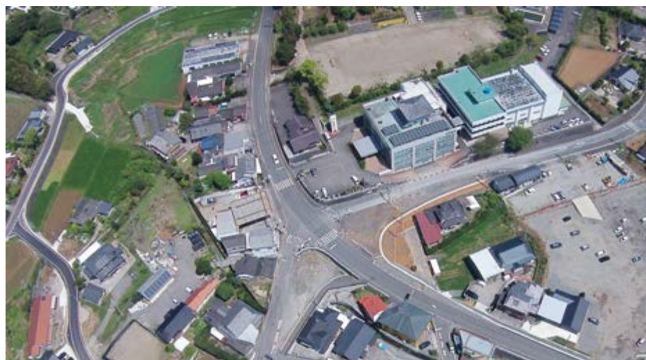
↑道路整備着工前の役場前交差点
